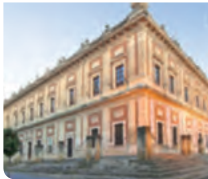
(3) Casa de Contratación, en Sevilla.
