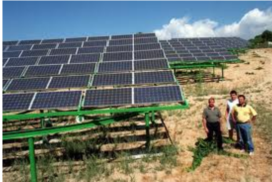
central solar fotovoltaica
