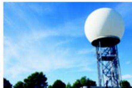
Los **radares meteorológicos** predicen las lluvias midiendo la distancia a la que se encuentran las nubes y la velocidad a la que se mueven. Existen muchos tipos de radares dependiendo de la frecuencia de la radiación que utilizan. Las señales se emiten y reciben mediante antenas.
