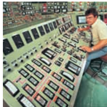
10.20 Aunque la sala de control de una central nucleoelectrónica es muy compleja, el principio físico en el que se basa el funcionamiento de la central es sencillo: parte de la energía en reposo de los núcleos atómicos se convierte en energía térmica, con la cual se produce vapor de agua para impulsar generadores eléctricos.
