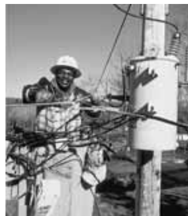
FIGURA 6-22 Reparación de un transformador de bajada en un poste de transmisión de alto voltaje.
