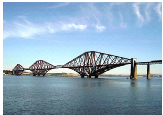
Puente ménsula, Puente ferroviario, Forth.
