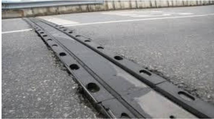
En un puente de 1 Km de largo la variación de longitud a altas temperaturas puede llegar a los 60 cm. Se les coloca unas juntas de dilatación que absorba este aumento de longitud.
