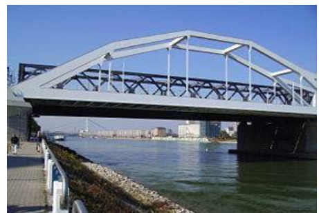
Puente fabricado de acero
