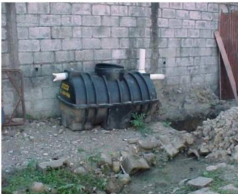
Fosa séptica prefabricada
